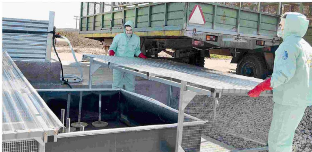
Ειδικό επιστήμονες του προγράμματος Life-EcoPest τοποθετούν ειδική πλαστική μεμβράνη σε δεξαμενή όπου γίνεται συγκέντρωση και διαχείριση υγρών αποβλήτων.
